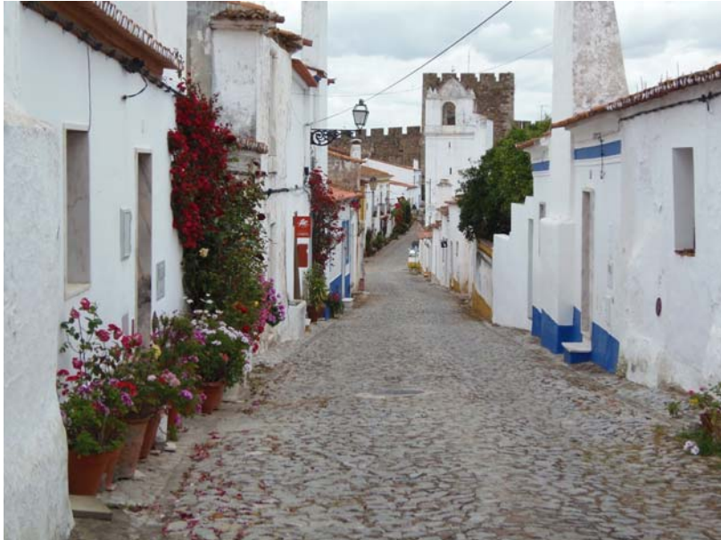
Figura 6: Rua Direita - construção tradicional
